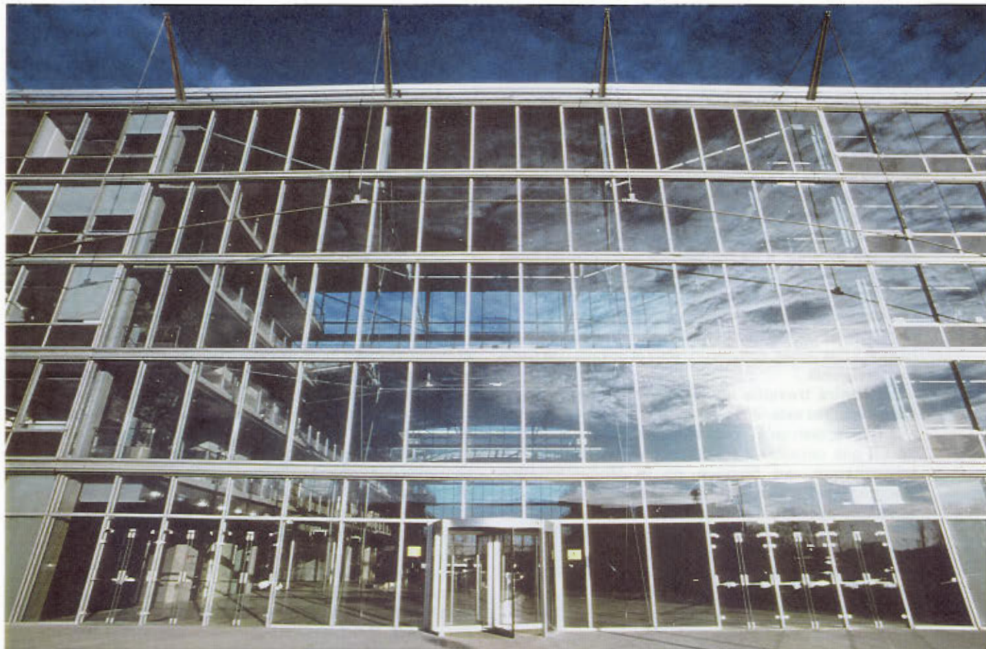
L'immeuble commun à l'Ecole Nationale des Sciences Géographiques et à l'Ecole Nationale des Ponts et Chaussées, dans lequel est implanté le nouveau Centre de Documentation de l'I.G.N.
