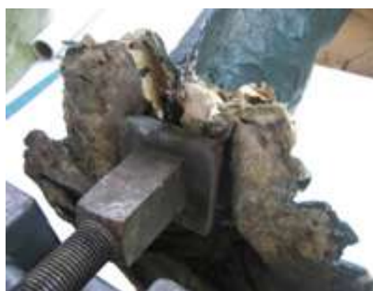
Figure 3 : Armature en métal dans un dauphin (avant sa restauration en 2010)
